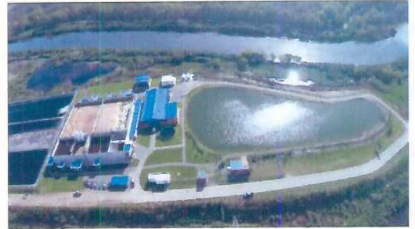
Planta de tratamiento de líquidos lixiviados, Norte III.
